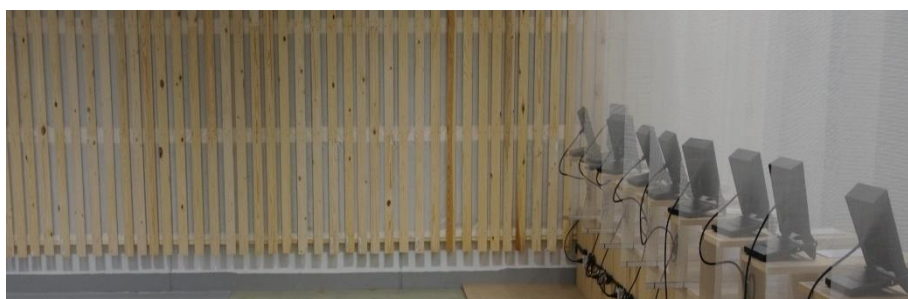
Bild 7:5. Träpalissad som tryckabsorberande och rikoschettskyddande material.
