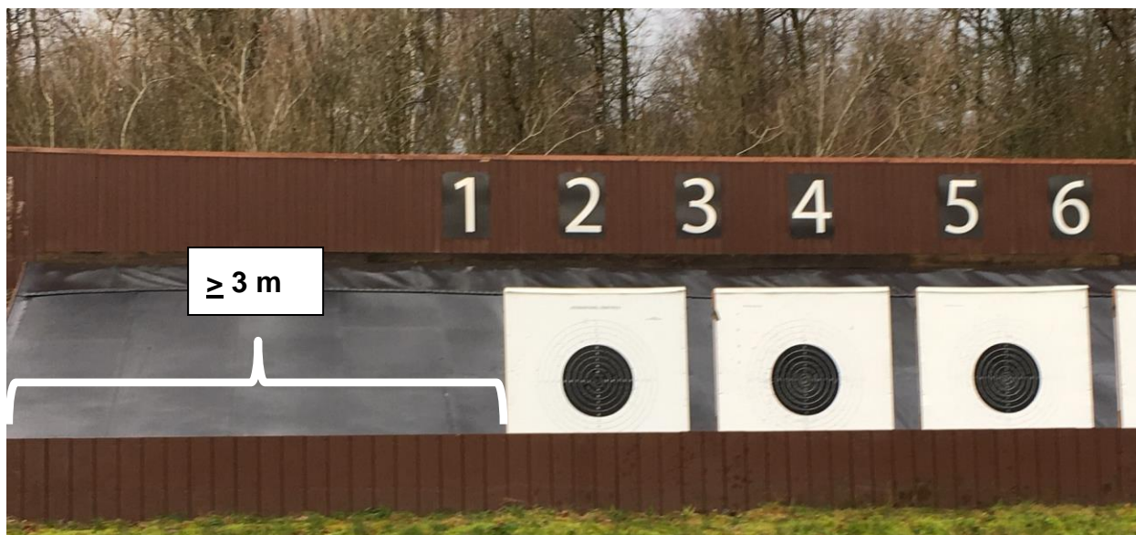
Bild 2:4. Kulfångsbredd vid skjutning mot mål/målställning
