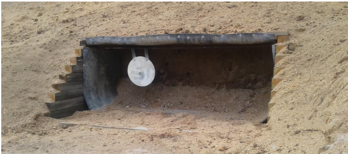
Bild 3:5. Kulfång med ingrävt splitterskydd för metallmål
